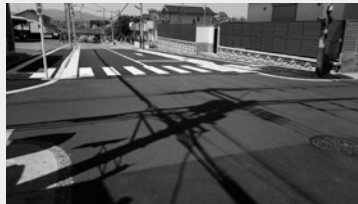
カラー舗装の事例（船橋通り）
